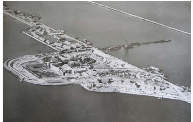
13. Luchtfoto werkeiland Lelystad. In het midden de bouwput voor het gemaal, rechtsonder de paar blokjes dienstwoningen, linksboven het werkkamp, uitlopend in de 'Lange Jammer' de werkplaats van de dijkenbouwers. Bron: Collectie Ed Voigt.
